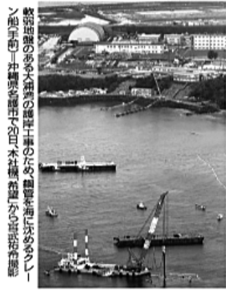
軟弱地盤のある大浦湾の護岸工事のため、鋼管を海に沈める作業の様子。沖縄県を撮影して20日、本誌「建設」から提供された。
